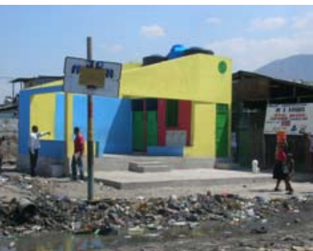
Quiosque público para fornecimento de água.
